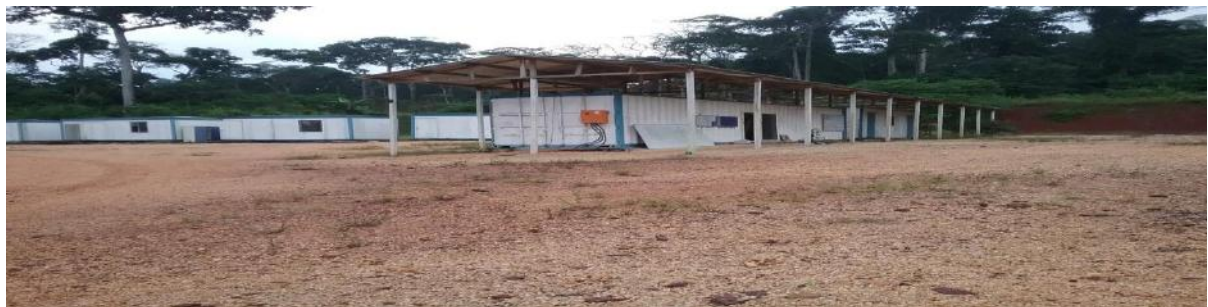
Bureaux à droite et logements du personnel expatrié de C & K MINING INC à gauche
