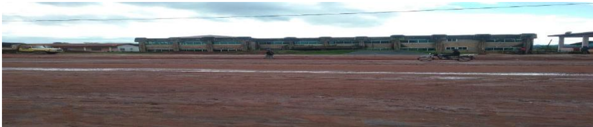
Hôtel de ville de Yokadouma en construction
